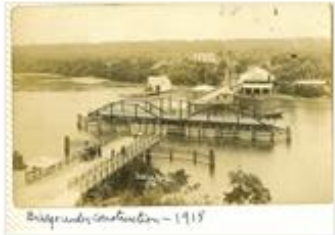
IR10 bridge 1915.jpg
